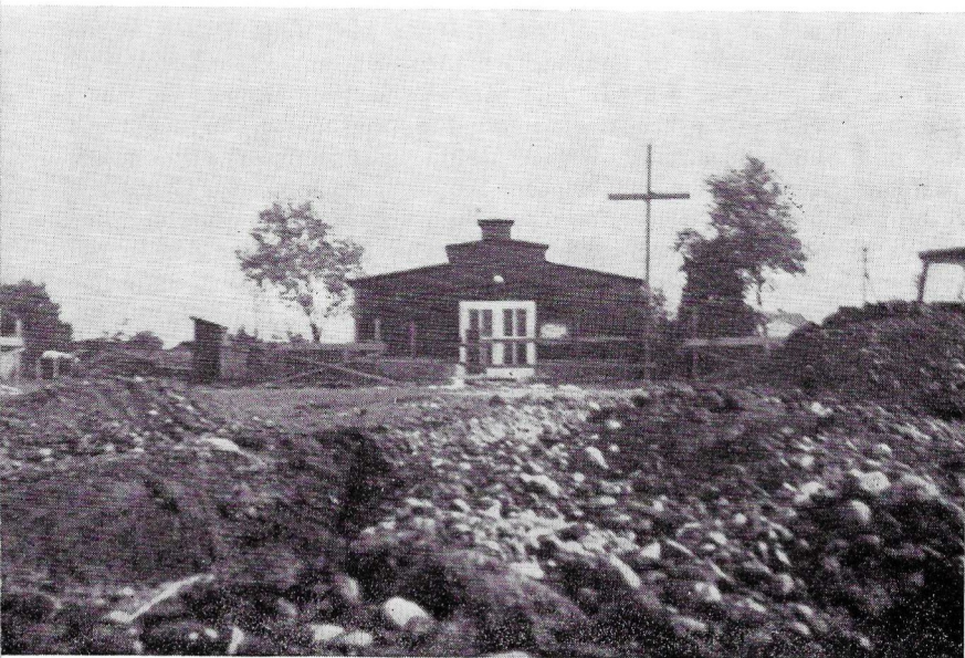
Alte Kirche unmittelbar nach Baubeginn.
